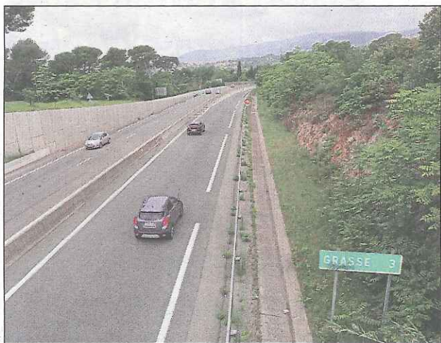
Une voie pour automobiles auparavant mal signalisée.
