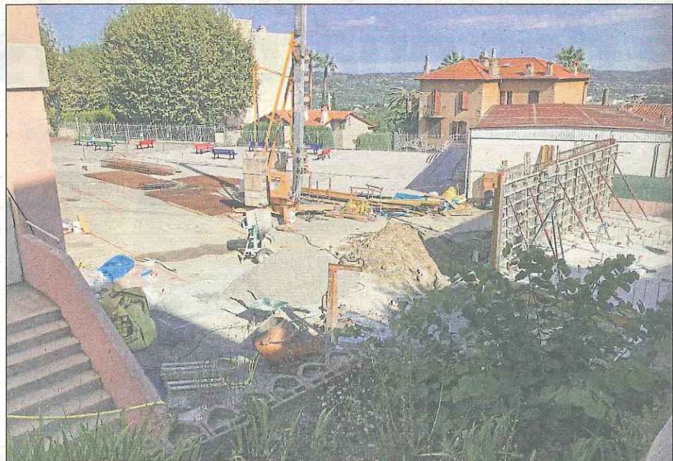
À la rentrée, le collège Carnot sera doté de nouvelles structures sanitaires.
