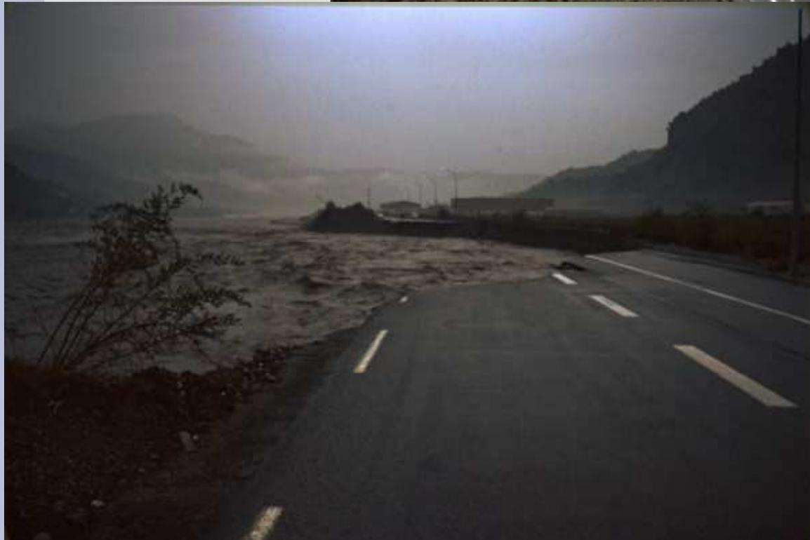
Rupture de la digue de la ZI de Carros lors de la crue de 1982 par érosion externe
